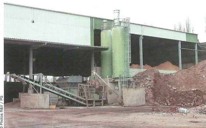
© Photos R&V / PG Une importante installation de production de graves et chaulage de terres chez GVT.
